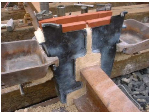
Figuur 2.88: Afdichte vormen met slakkenbakken
