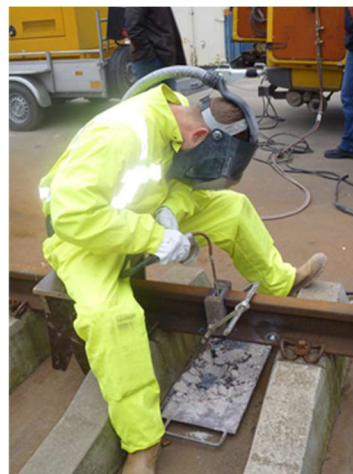
Figuur 2.66: Bekistlassen met 'Innershield'
