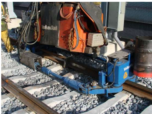
Figuur 3.14: Afbrandstuiklassen
