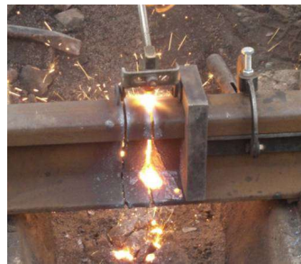
Figuur 2.43: 3e snede in de kop
