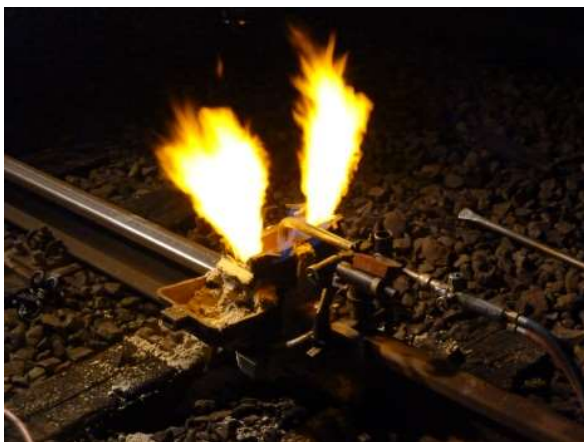
Figuur 2.89: Voorverwarmen thermietlas
