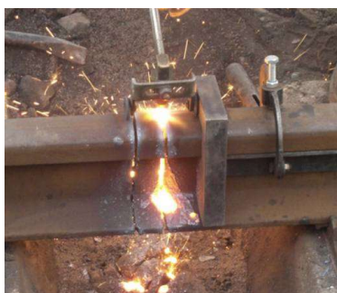
Figuur 2.33a: Snijden met een snijbeugel
