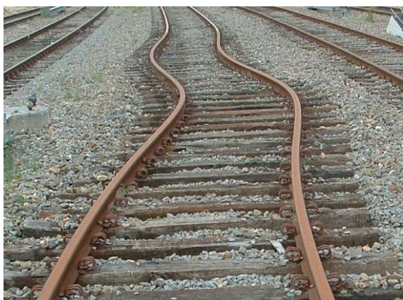
Figuur 3.20: Spoorspatting
