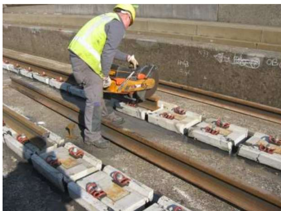
Figuur 3.37 Slijpen in blokken spoor
