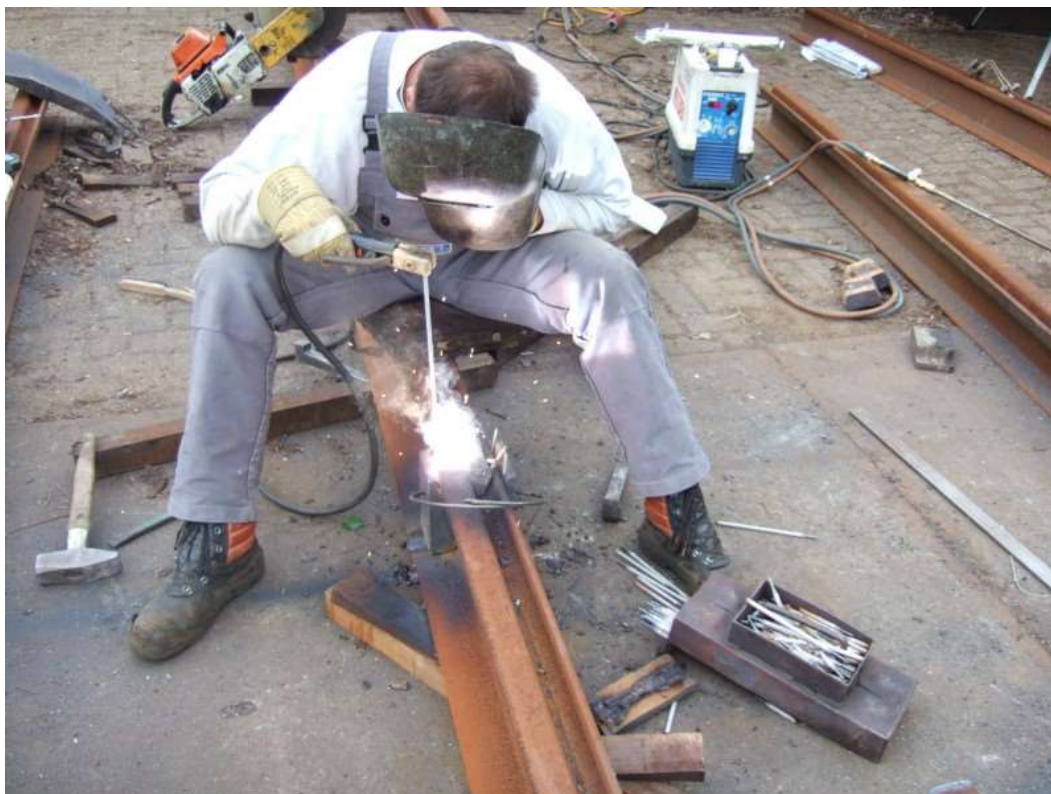
Figuur 2.45: Bekistlassen door middel van booglassen met beklede elektrode
