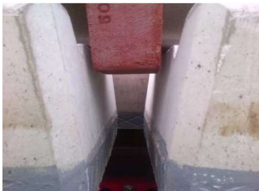
Figuur 3.38 Beperkte ruimte tussen blokken en vorm
