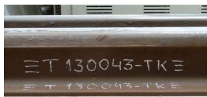
Figuur 5.3: Door lassers aan te brengen markering na herstel door oplossing van een defect met een us-nummer (nummer nooit verwijderen)
