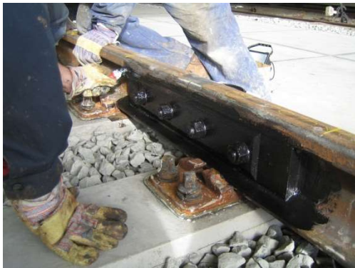
Figuur 3.18: Isolatielas / ES-las
