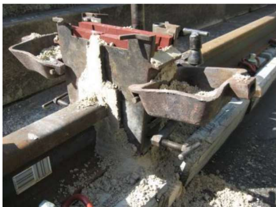
Figuur 3.39 Afdichten vorm en voorverwarmen
