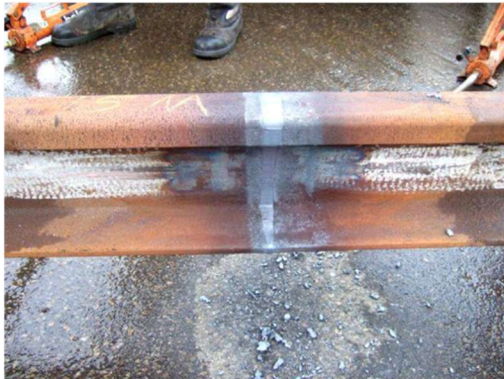
Figuur 2.84: Voorbeeld van een mobiele afbrandstuiklas
