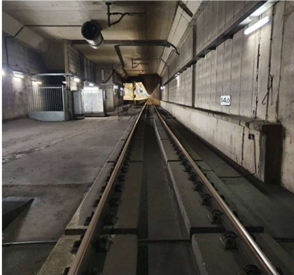
Figuur 3.36 Blokken spoor in een tunnel
