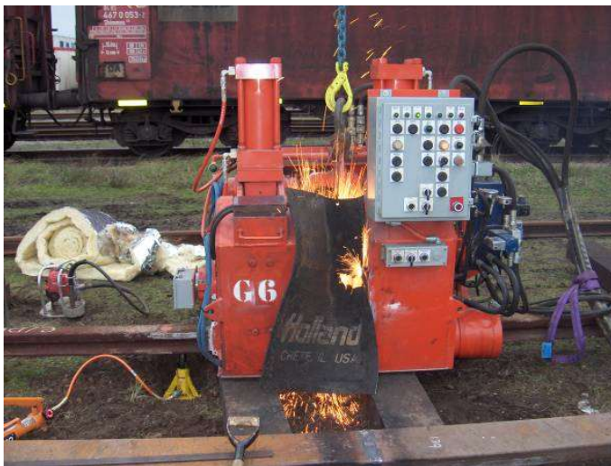
Figuur 2.82: Voorbeeld van een laskop van een mobiele afbrandstuiklasmachine
