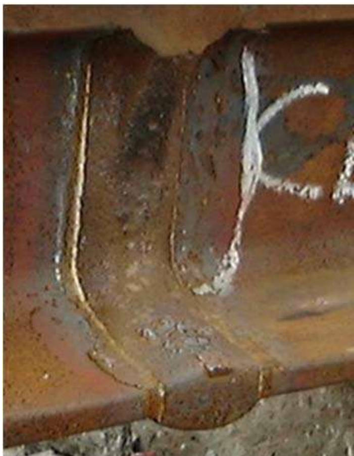
Figuur 1.79: Geoxideerde/verglaasde en bolle lasrand bij thermietlas
