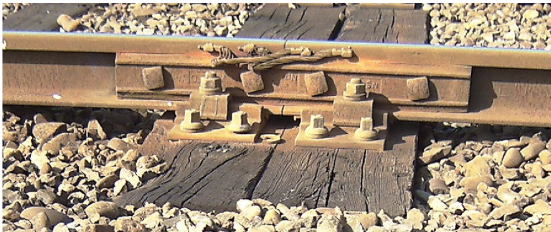
Foto 1; Voorbeeld van een plaatlas in een gemend ballastbed. De foto is midden in de zomer gemaakt, de voeg is (nagenoeg?) gesloten.
