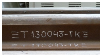
Figuur 4. Door lassers aan te brengen markering na herstel door oplassing van een defect met een us-nummer (nummer nooit verwijderen)
